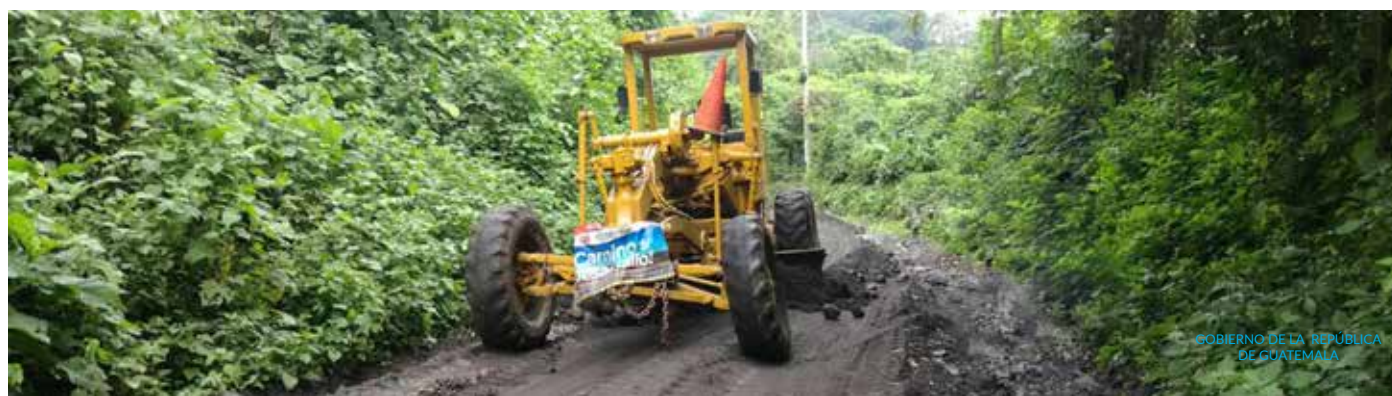
Trabajos de reposición de balasto, en Ruta Departamental de Escuintla. MICIV
