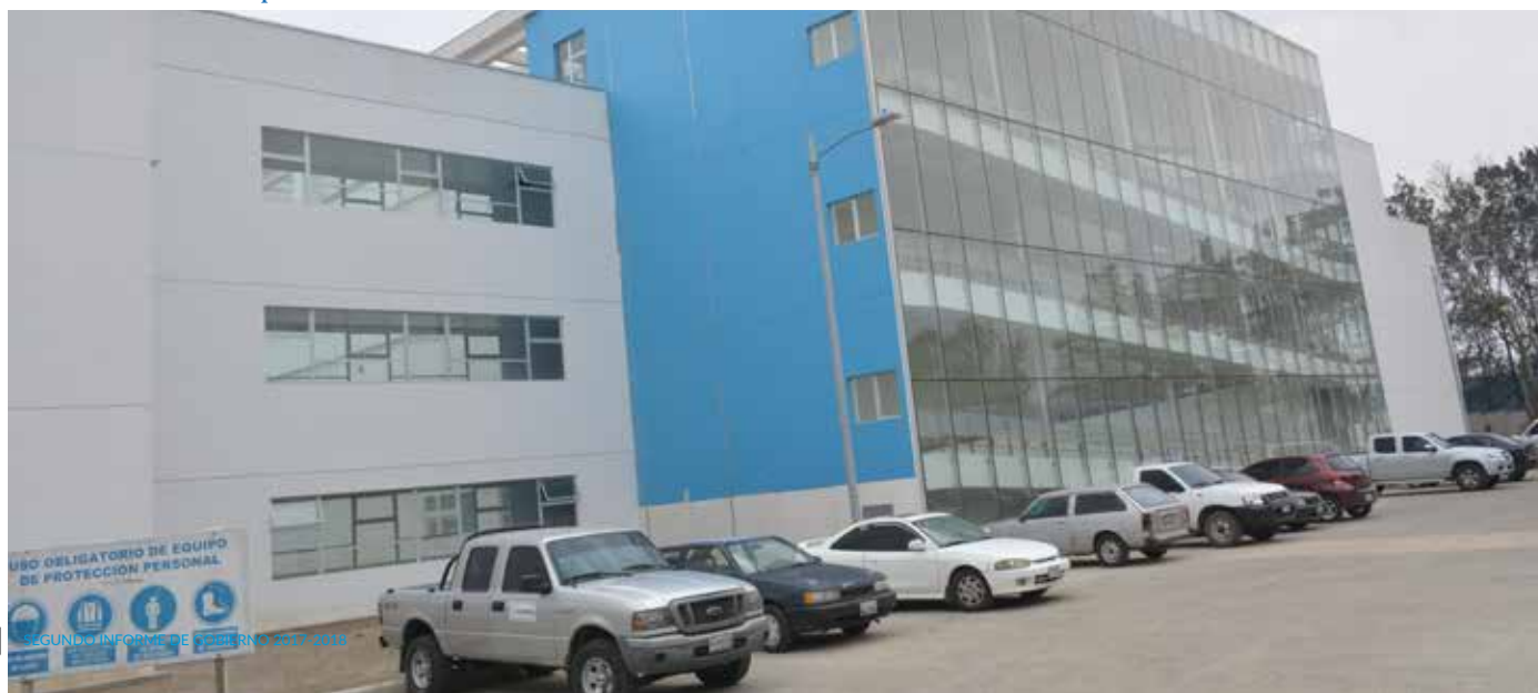
Instalaciones del nuevo Hospital General de Villa Nueva. MSPAS
