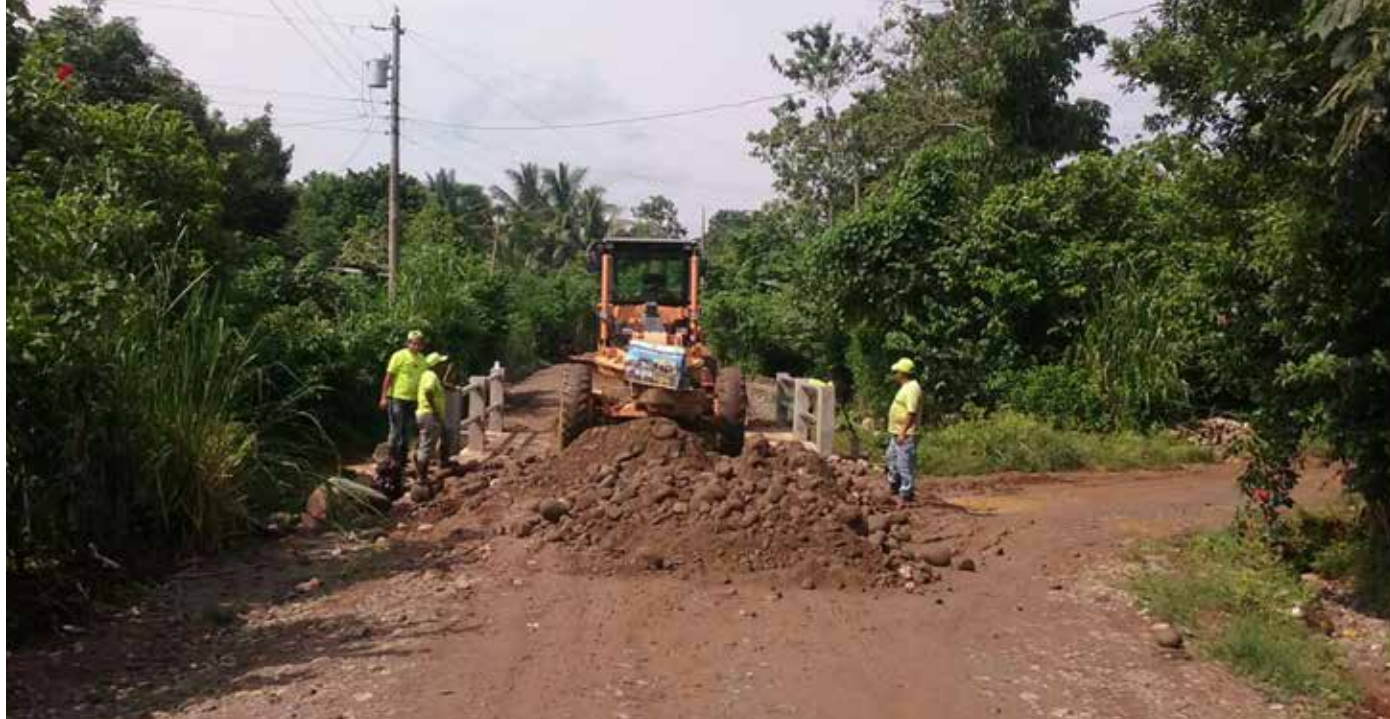
Trabajos de aproche de puente y reposición de balasto, en Ruta Departamental San Marcos 50 –RD-SM-50–, Municipio de Malacatán, San Marcos. MICIV
