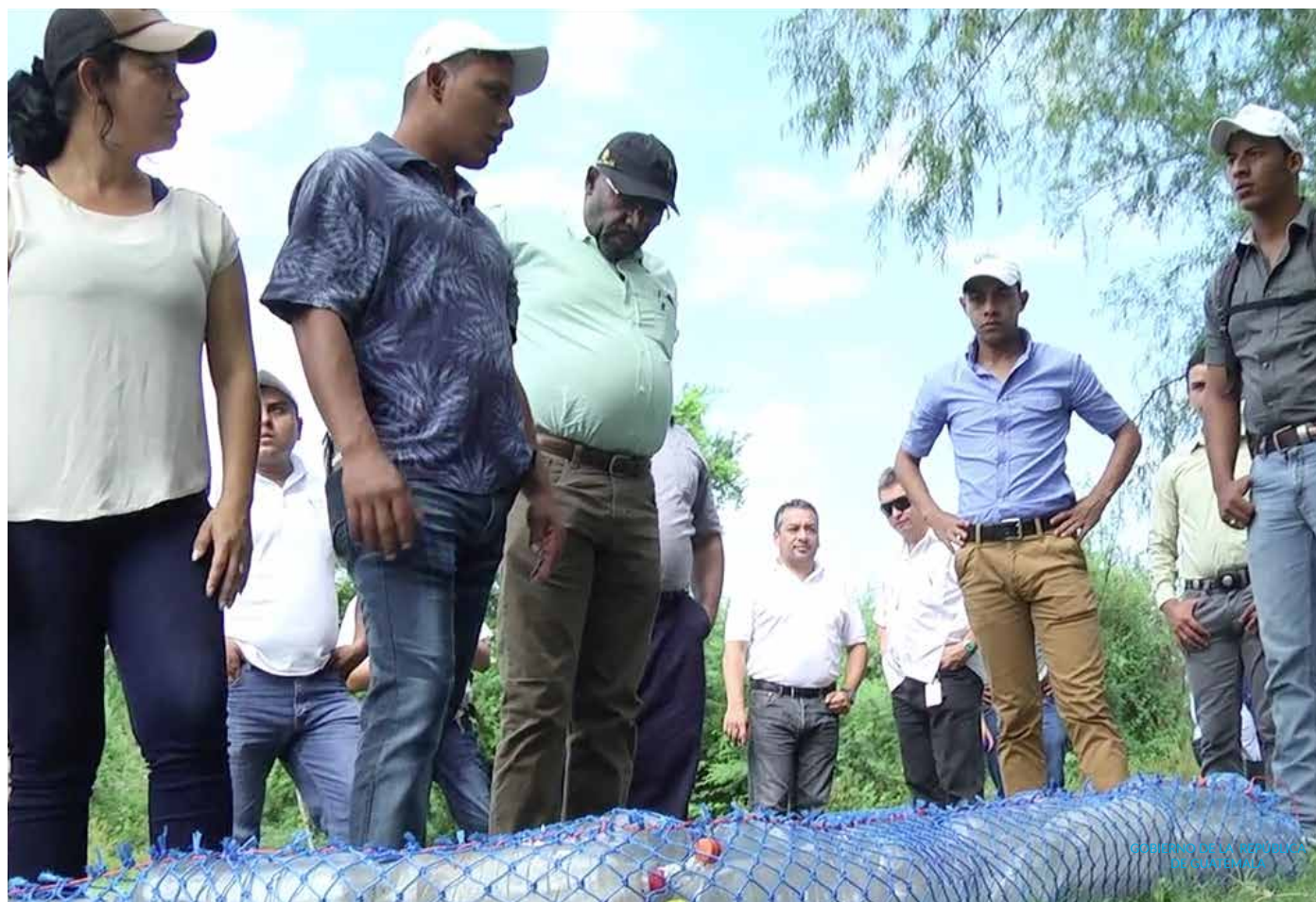
Trabajos de instalación de Biobardas. MARN
