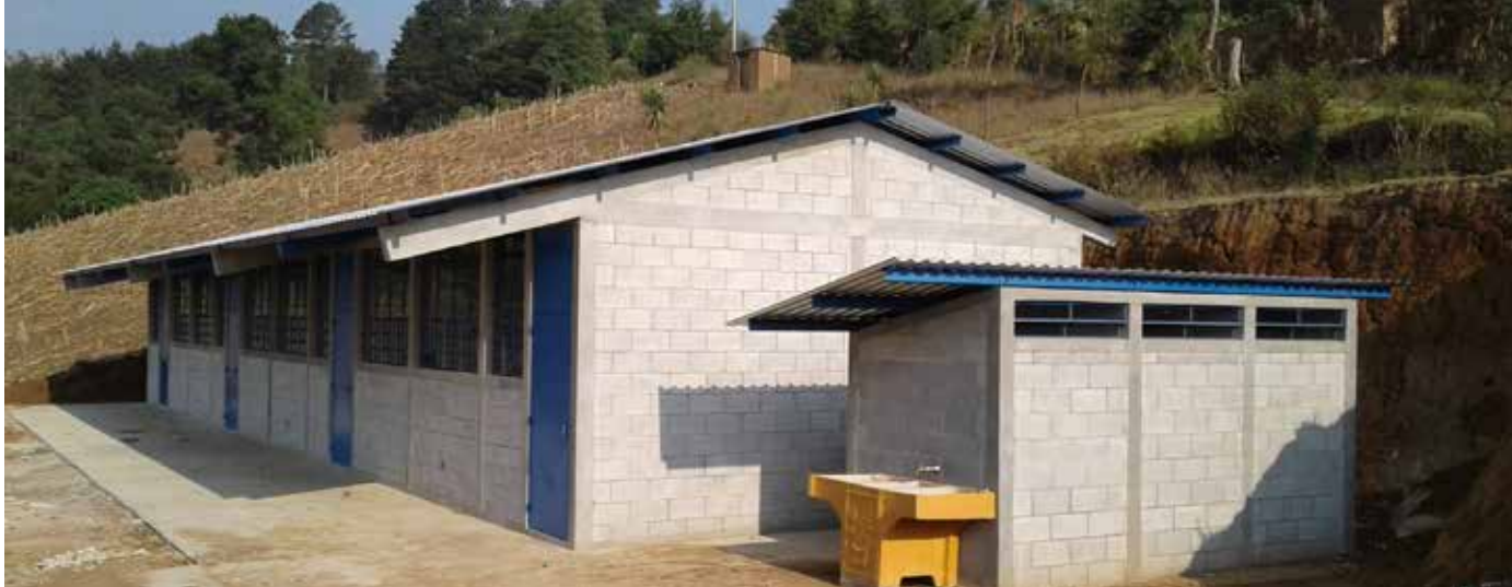
Construcción Instituto Básico, Caserío Las Brisas, Mataquescuintla, Jalapa. SCEP
